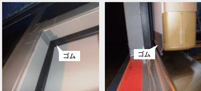
①上枠及び召合わせに設置した気密ゴム
